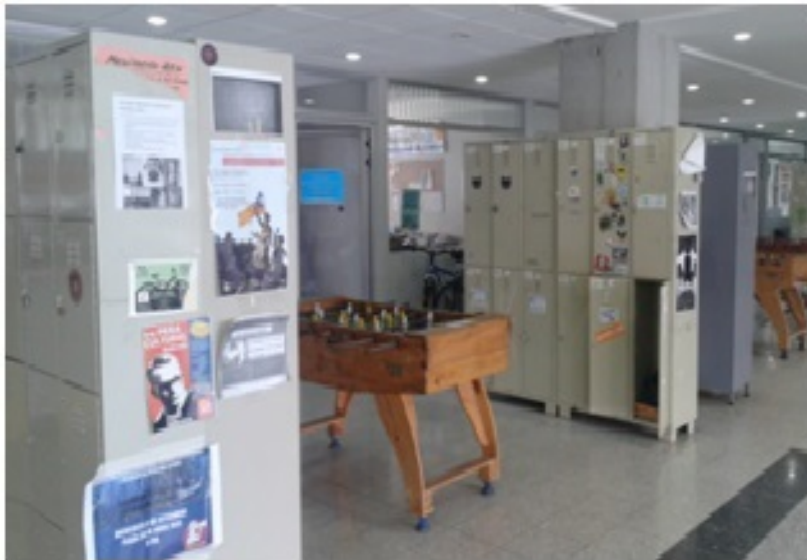
Imagen 3. Casilleros sin elementos de anclaje
